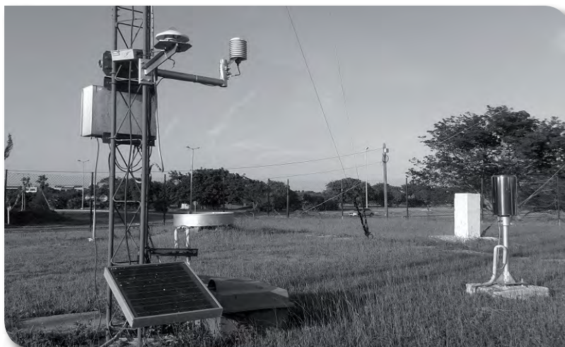
Estación meteorológica automatizada
