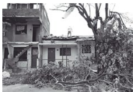
Figura 3.2: Derrumbes provocados por los vientos del huracán Sandy
