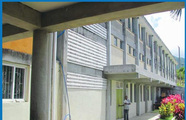
■ USE OF CANTILEVER CONCRETE SLABS TO COVER WALKWAY
