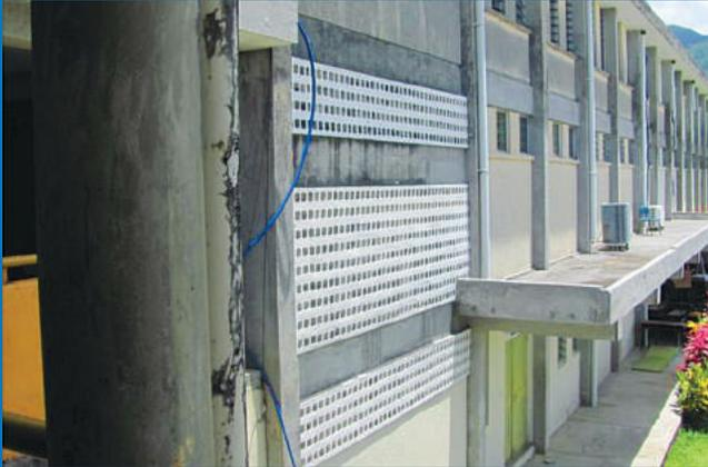
■ USE OF CANTILEVER CONCRETE SLABS TO COVER WALKWAY
